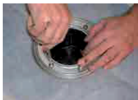
5. A nemesacél tárcsát a csavarokkal leszorítjuk
