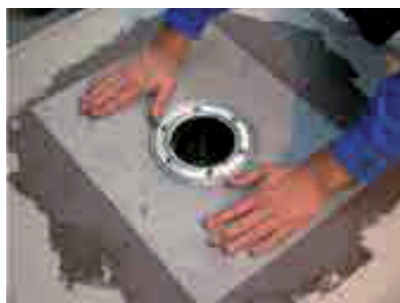
8. A fóliát rásimítjuk a kent felületre
