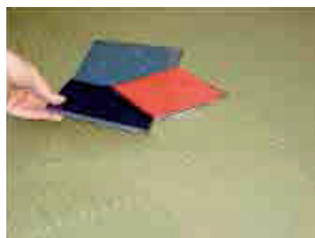
12. A magasítót tömítőgyűrű nélkül behelyezzük és csempézzük
