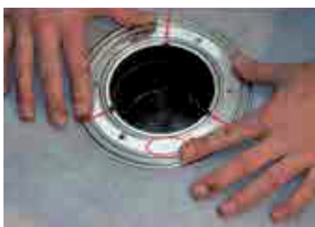
4. A szigetelő fóliát a karimára fektetjük, a leszorító tárcsát a megfelelő oldalával, a helyezőkörmöknek megfelelően ráfektetjük
