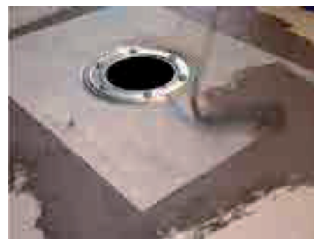
9. Majd a fólia felső oldalát, a többi szigetelendő felülettel együtt szigeteljük
