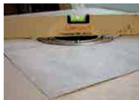
6. A szigetelő készlet az aljzatbeton síkja alatt van.
