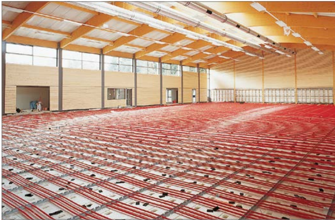
11-60. ábra: Lengőpadlófűtés osztó-/gyűjtőcsővel
