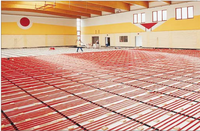
11-54. ábra: Lengőpadlófűtés standard osztó-gyűjtővel
