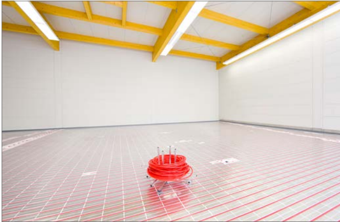
11-42. ábra: Száraz fektetésű rendszer rugalmas felületű sportpadlóval
