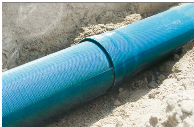
11-70. ábra: A drénezés lefektetése a játéktéren
