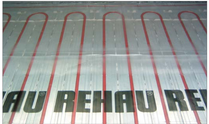
4-155. ábra: TS-14 száraz fektetésű rendszer
