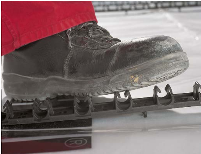
4-133. ábra: RAUFIX-sín benyomása padlószervezetbe.
