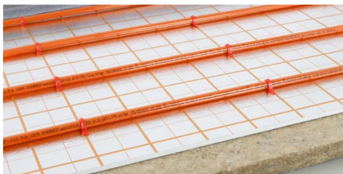
4-100. ábra: RAUTAC 10 rendszer fektetése már meglévő szigetelésre
