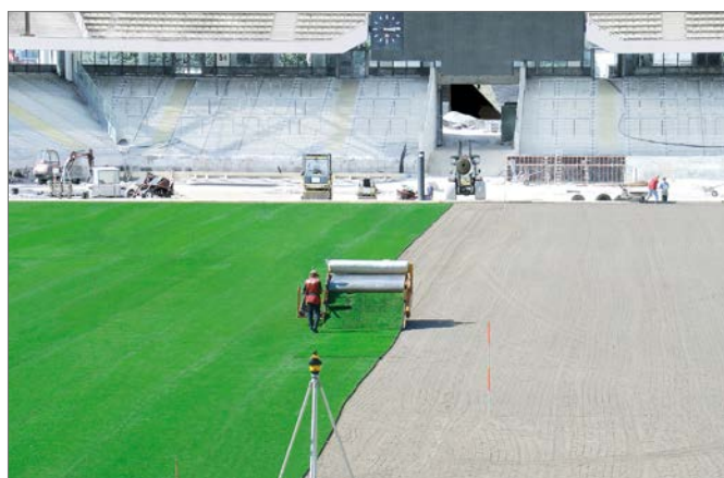
11-72. ábra: A hengerelt gyepszőnyeg lefektetése
