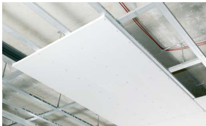
6-11. ábra: Felszerelt mennyezeti elem
